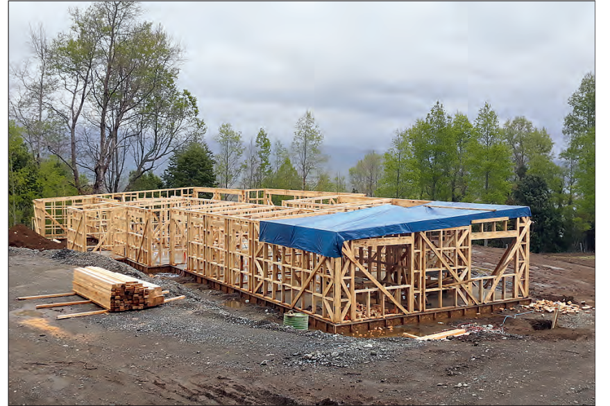
Gebäude in Holzrahmenbauweise in der Bauphase, aufgenommen in der Regenzeit (oben), und ein Haus (unten), das sich augenscheinlich schon lange in der Bauphase befindet.
