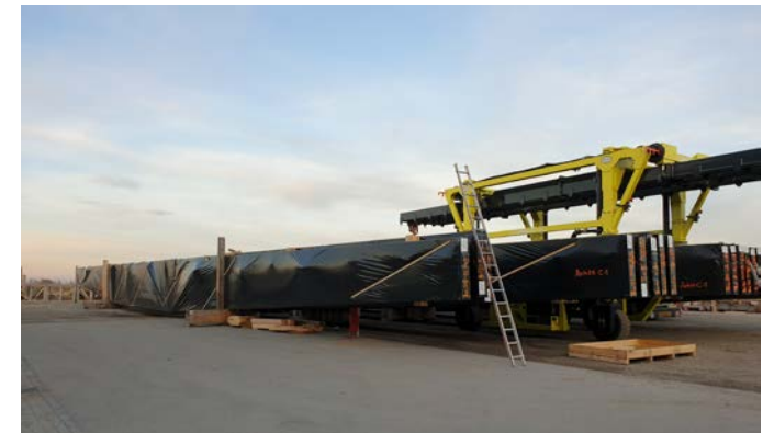
50m Träger mit Verladungskran
