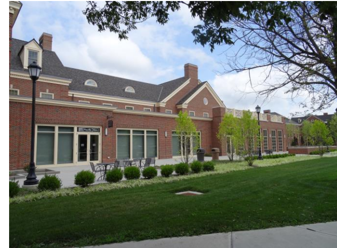
Typische Backsteingebäude auf dem großen Campus
