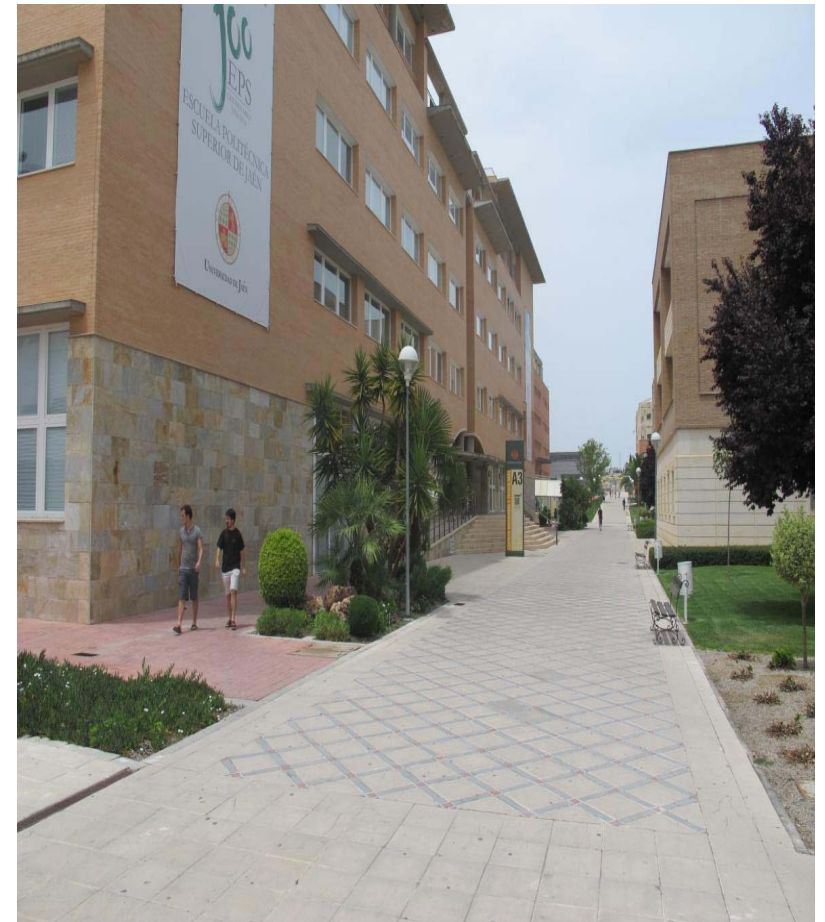
Links das Gebäude der Professoren für Ingenieurwesen
